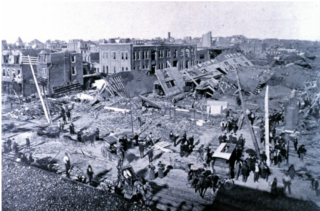
Daño del tornado, Union Depot, Jefferson y Avenida Allen, Tornado St. Louis, Mayo 1896.
